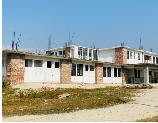
बिरतामोड(प्रस) । बिरतामोड नगर अस्पताल नयाँ भवनमा सञ्चालन गर्ने तयारी अन्तिम चरणमा पुगेको छ । अस्पतालको निर्माणधिन
